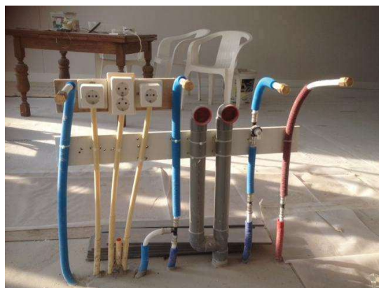
Afbeelding toont de gewenste ordelijke installatiewijze van het leidingwerk (let op: het benodigde leidingwerk is situatieafhankelijk)
